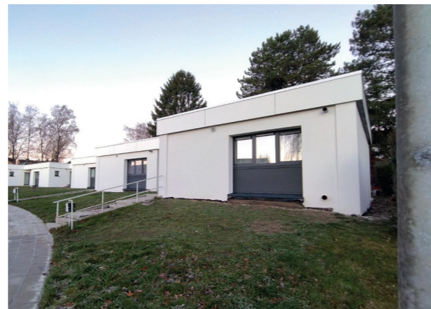
Energetische Sanierung Theodor-Mooren-Str. Eupen
