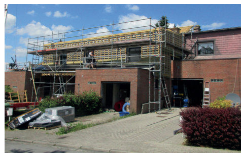
Energetische Sanierung Parkstr. Astenet
