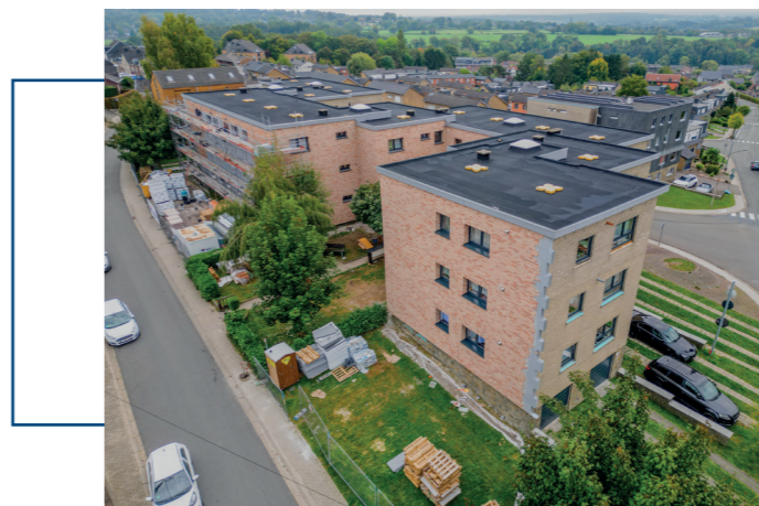
Energetische Sanierung Sandweg Kelmis
